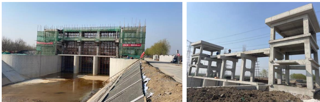
图 2.3-5 在建东营节制闸、诸顺闸节制闸
