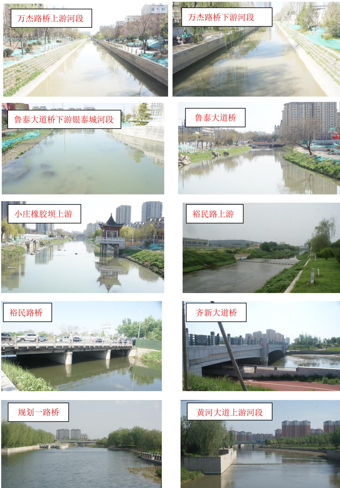
图 2.3-3 高新区河道现状
