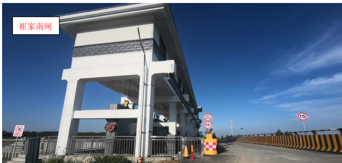
图 2.3-4 桓台县河道现状
