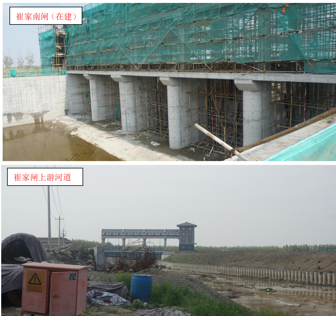
图 2.3-4 桓台县河道现状
