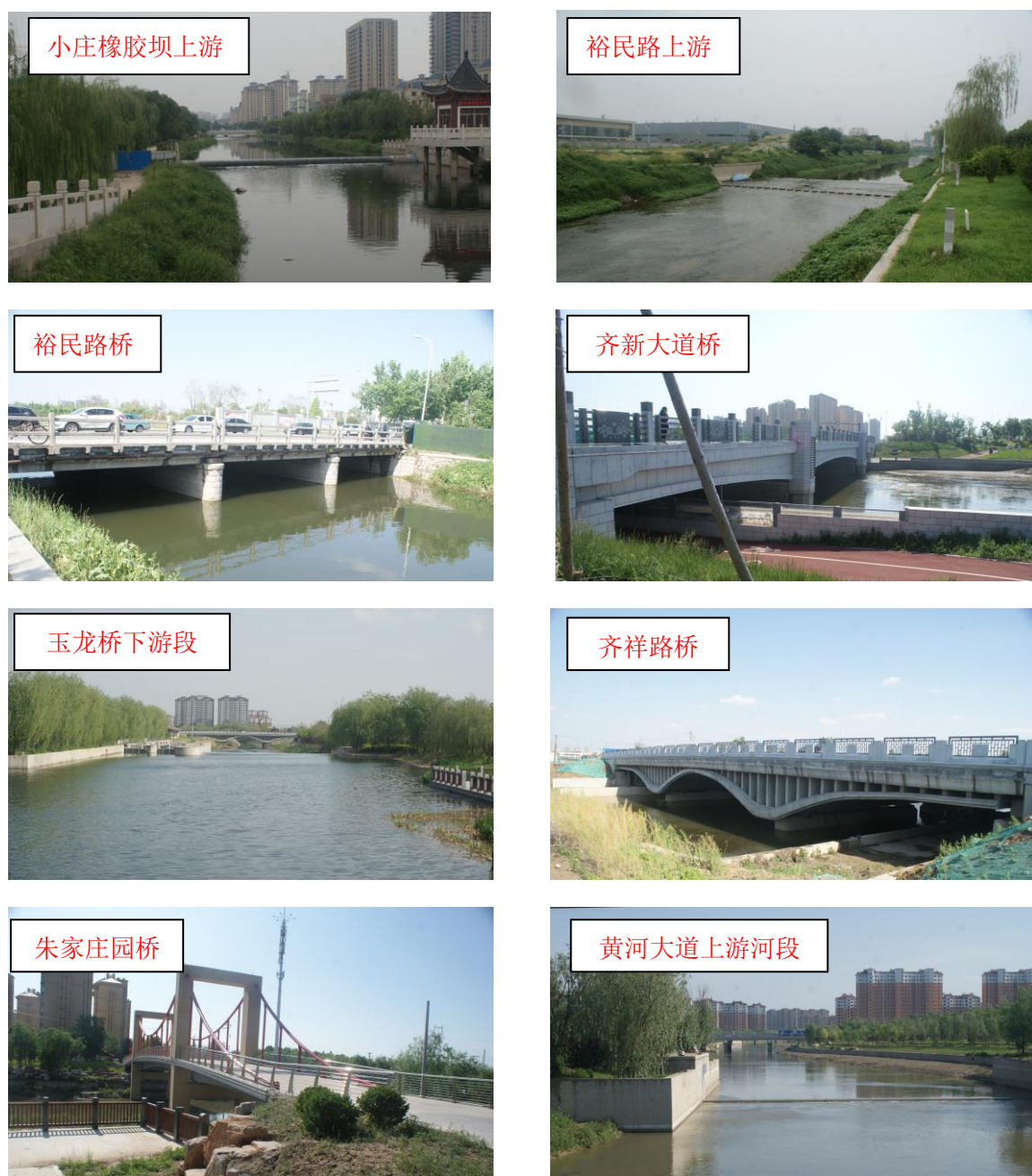
图 2.3-3 高新区河道现状
