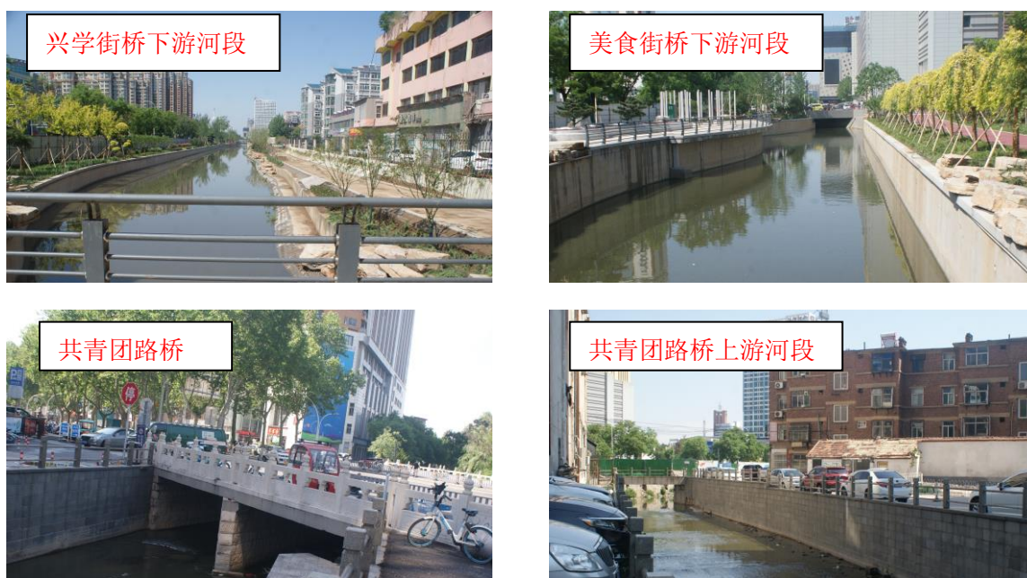
图 2.3-2 张店区河道现状
