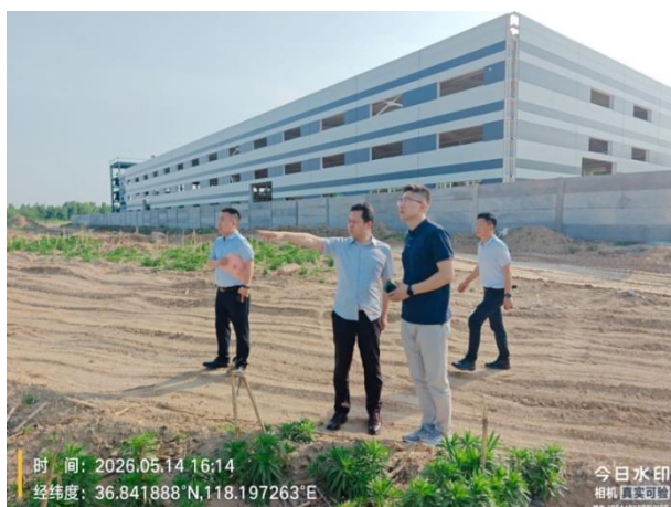
工程师现场勘察情况
