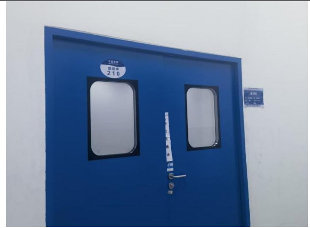
备用间西侧工艺辅房
