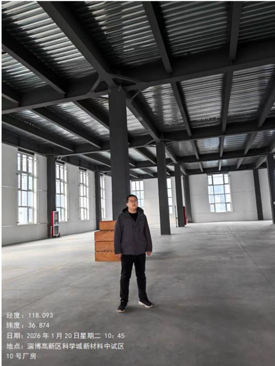
附图7 工程师现场勘查照片
