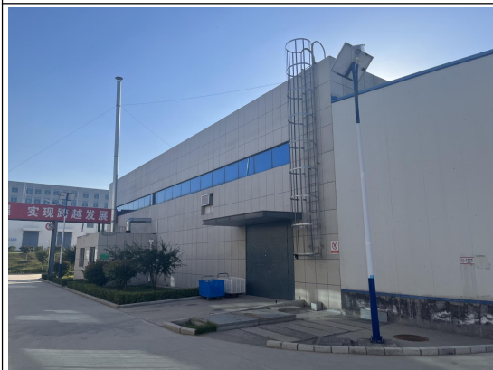
依托现有项目排气筒
