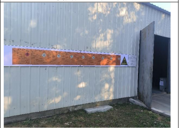
依托现有项目危废暂存间
